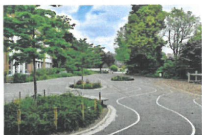
Limite des espaces vert pleine terre par ganivelles h=0.5m Délimitation des circuits par marquage au sol peinture blanche
